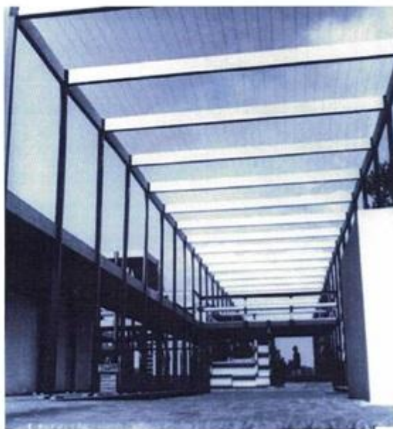
Vista de pérgola central y recepción
